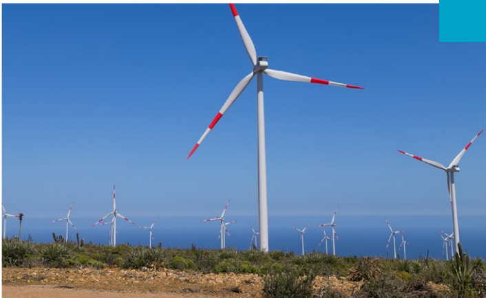
Parque eólico Cururos
