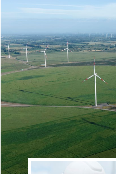
Parque Eólico San Matías
